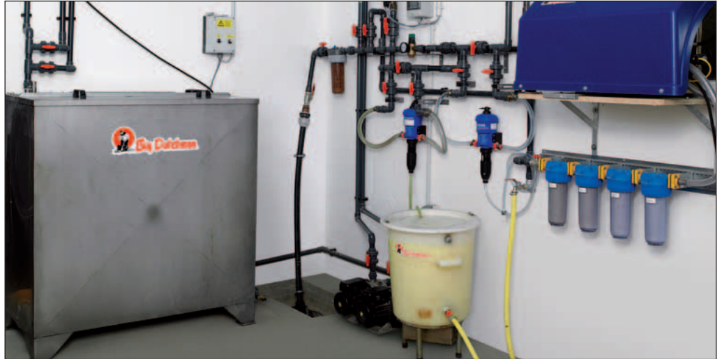
Предверие с малки и големи съдове за разбъркване на медикаментите
