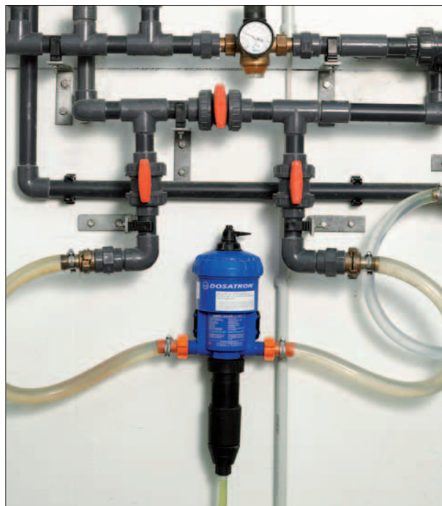
Разпределяне на водата с медикатор
