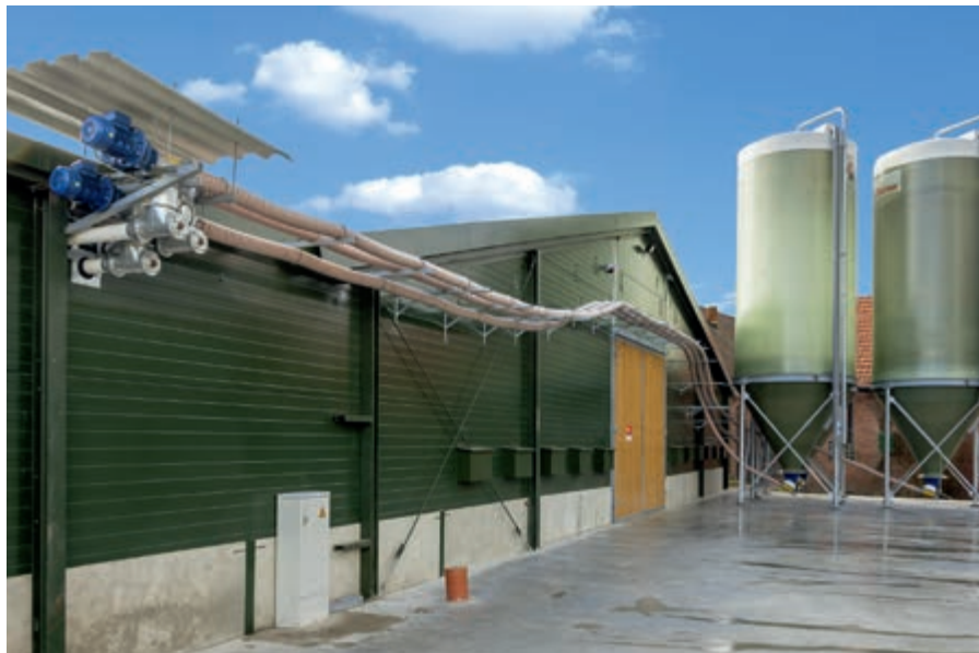
Използване на FlexVey PUR на 100% – от силоза до сградата
