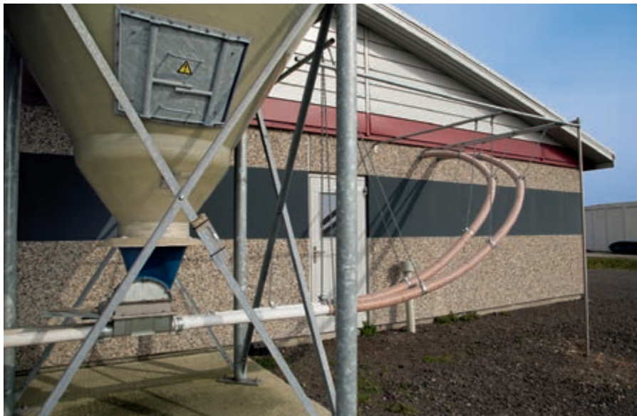
Монтаж на FlexVey PUR в комбинация с неподвижно закрепена тръба FlexVey
